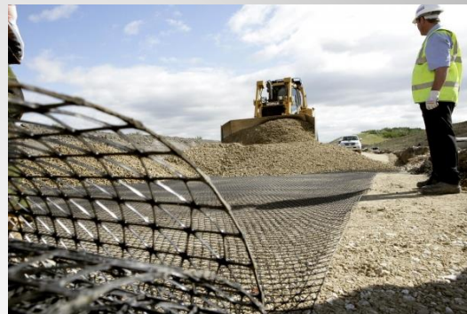
Композитная геосетка в дорожном строительстве.
